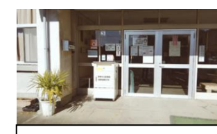
早園地区センター (正面入口左)
