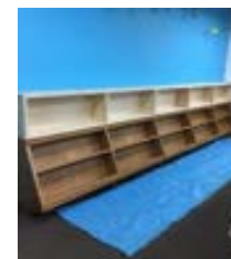
児童書架の工事の様子
